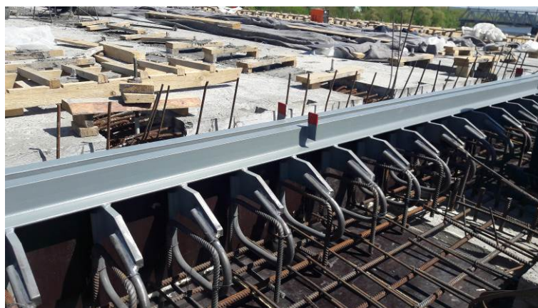
Рис. 3 – Монтаж деформационного шва системы «MAURER» типа МММ.Д-80
