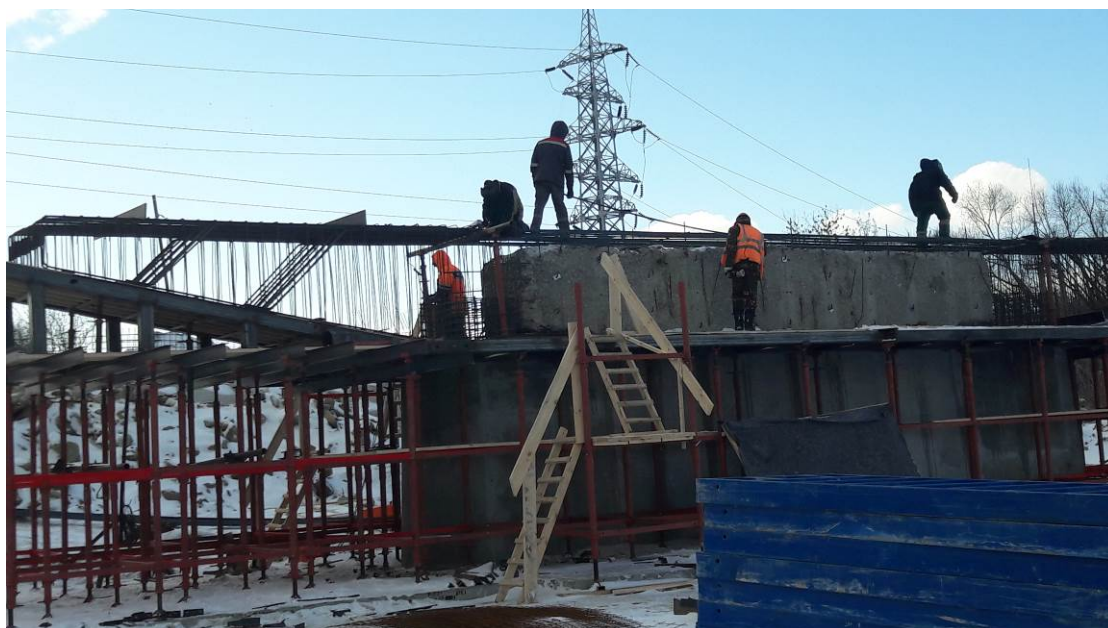
Рис. 4 – Устройство арматурного каркаса ригеля опоры мостовой конструкции
