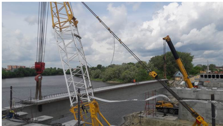
Рис. 2 – Монтаж тавровой железобетонной пролетной балки длиной 33 м.
