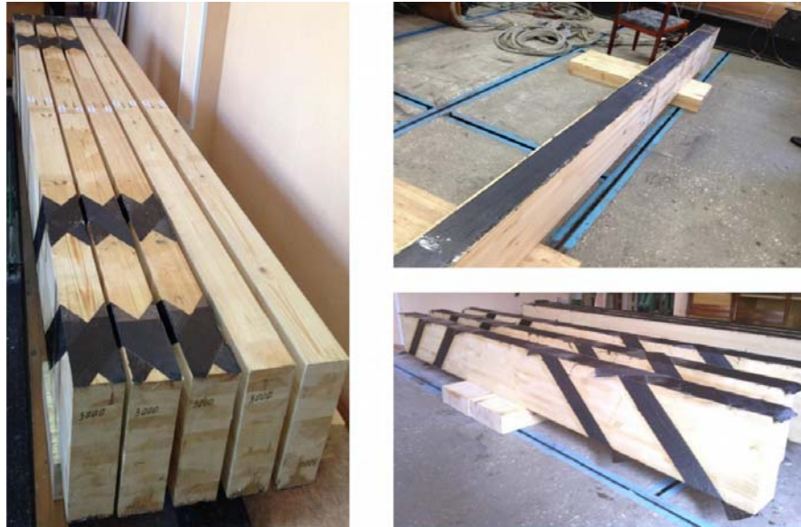
Рис. 2. – Внешнее армирование несущих деревянных конструкций углеродной лентой.
