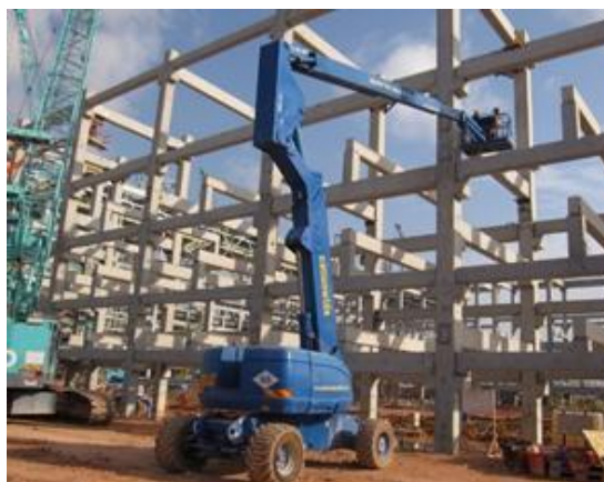
Рис. 7. – Монтаж несущих элементов системы I-SQRIM [14]
