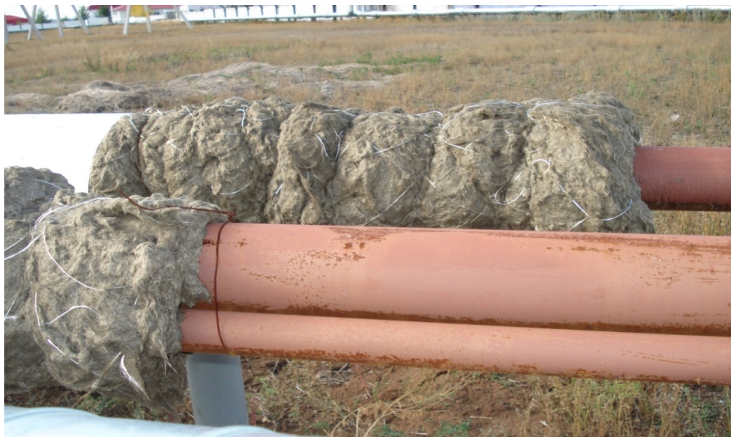
Рис.1. – Усадка минеральной ваты
