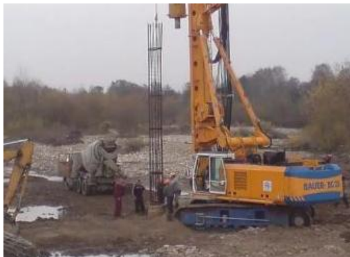
Рис. 7. - Погружение арматурного каркаса с помощью вспомогательной лебедки буровой установки.
