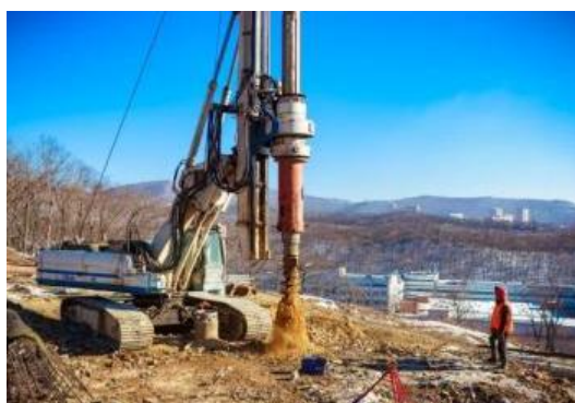
Рис. 5. - Процесс бурения скважины.
