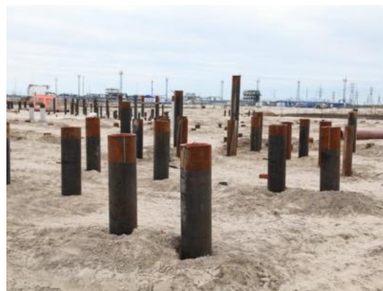
Рис. 2. - Свайное основание для компрессорной станции.
