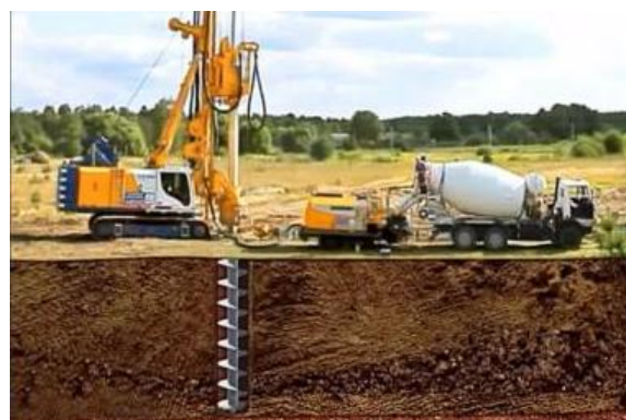
Рис. 6. - Бетонирование сваи с помощью бетононасоса.
