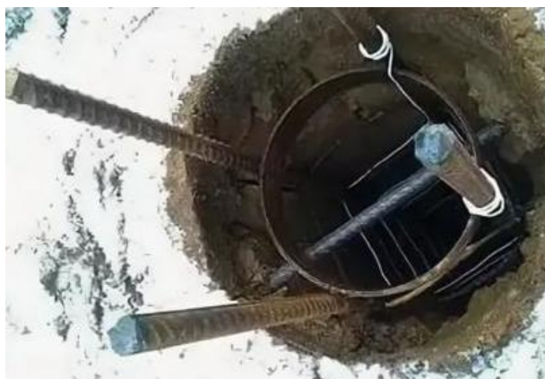
Рис. 3. - Каркас буроопускной сваи.
