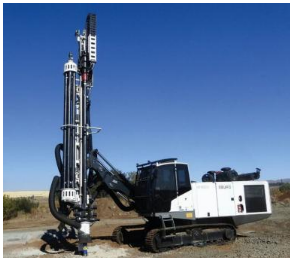
Рис. 4. - Буровая установка на точке бурения перед началом работ.
