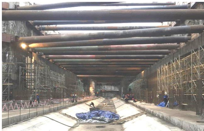
Рис. 2. – Открытый способ строительства станции метро «Народное Ополчение» (авторская разработка).
