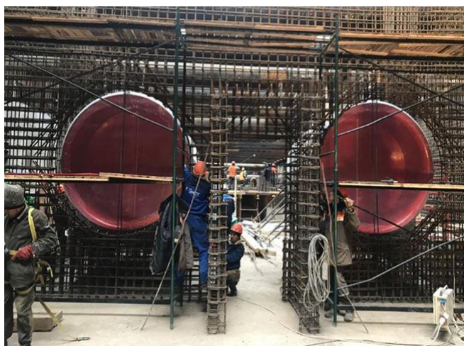
Рис. 5. – Тоннельные вентиляторы (авторская разработка)
