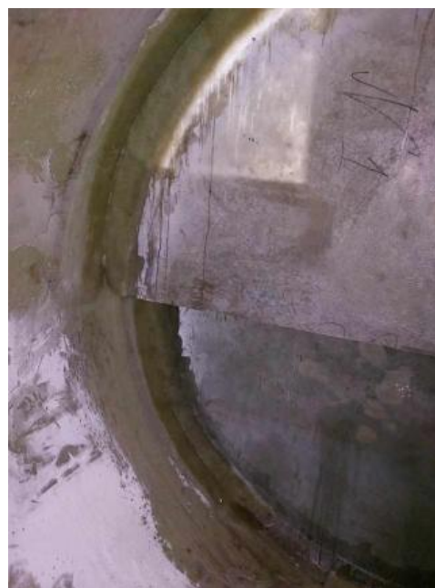
Рис. 6 Обследование стеклопластиковой емкости, выполненной методом непрерывной намотки
