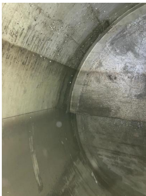
Рис. 5 Обследование стеклопластиковой емкости, выполненной методом непрерывной намотки
