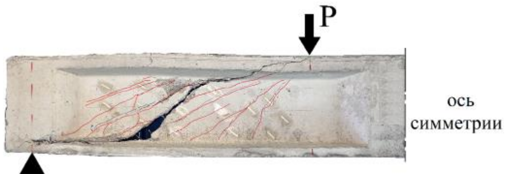
Рис. 3. – Общий вид балки Б3.2-Н-0.7 после испытания
